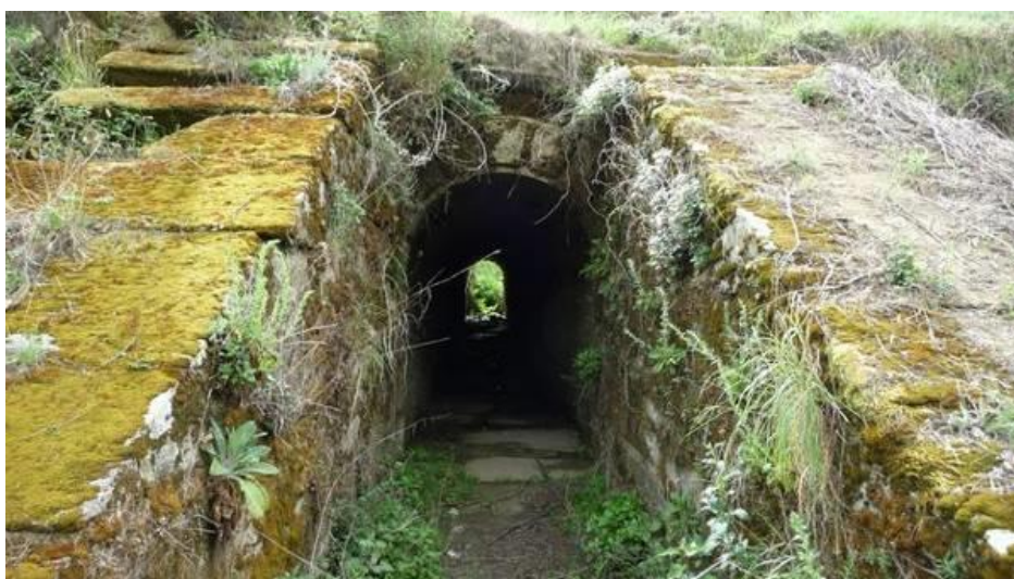
Fotografia 91 – Passagem hidráulica (abril/2012)
